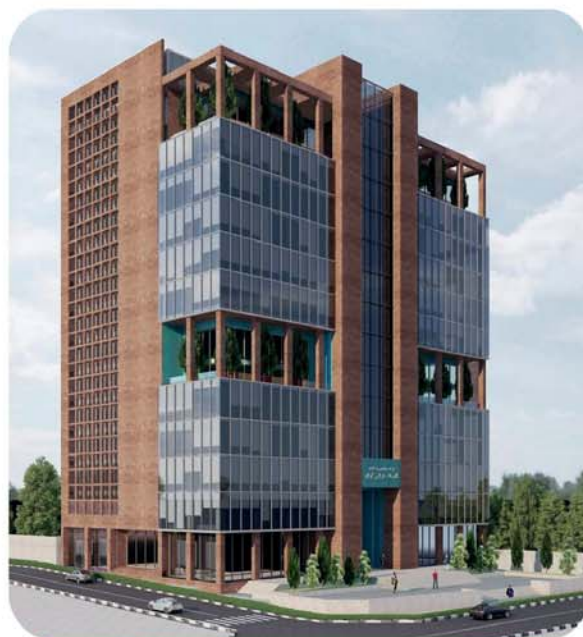
پروژه ساختمان اداری تاسیسات
