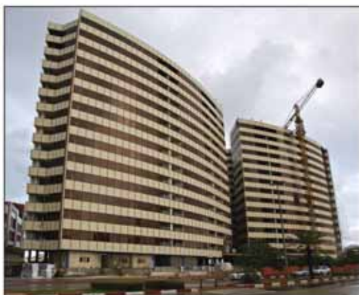
مجتمع مسکونی و تجاری دیپلمات
