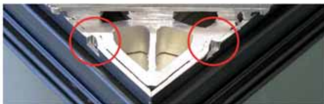
محل اتصال پروفیل شکافته شده با لقمه پنچ
