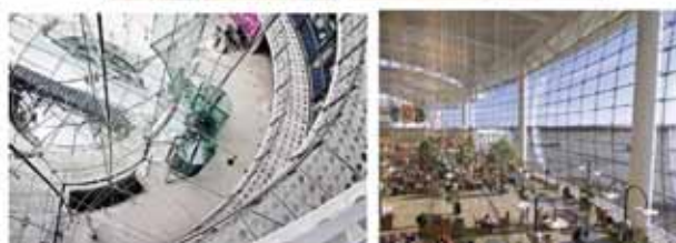
شکل (۱) شبکه کابلی تخت و منحنی در نماهای شیشه‌ای: هتل کمپینسکی (بالا چپ)، New Poly Plaza در پکن (بالا راست) دفتر مرکزی کانال ۴ لندن (پایین چپ)، فرودگاه بین‌المللی سیاتل در واشنگتن (پایین راست)
