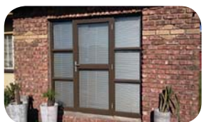
شکل ۱۲. پوشش‌های آندایز علاوه بر زیبایی و ایجاد رنگ‌های متنوع باعث مقاومت بیشتر در مقابل عوامل جوی نامناسب می‌گردد
