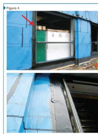
پوسته های کرتین وال انعطاف پذیر که به عنوان محافظ در برابر تغییرات جوی عمل کرده، سدی در مقابل نفوذ آب و هوا می شوند
