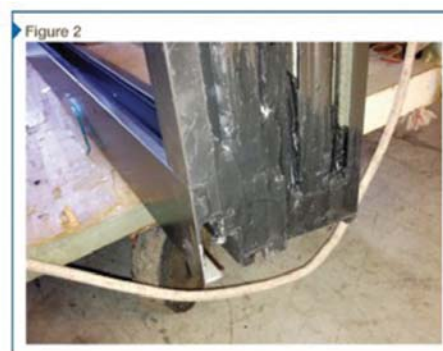
قاب آلومینیومی به همراه نصب درزگیر در گوشه‌ها
