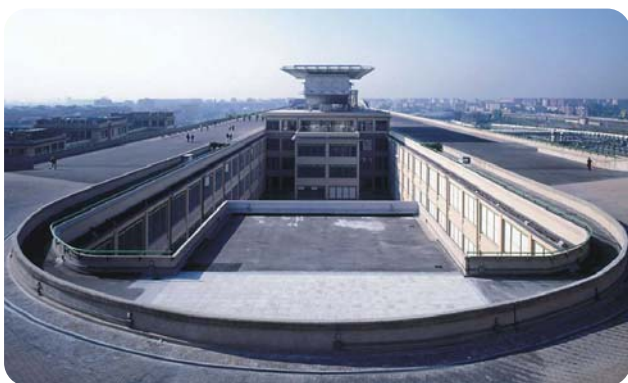
ساختمان تأسیسات شرکت اتومبیل سازی فیات - شهر تورینوایتالیا
