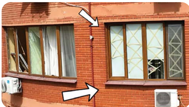
چسب زدن به لبه‌های شیشه و قاب، استحکام را افزایش می‌دهد
