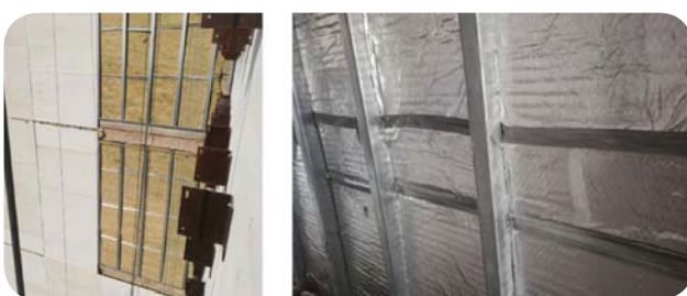
استفاده از پشم سنگ به عنوان عایق حرارتی در بخش میانی سازه LSF
