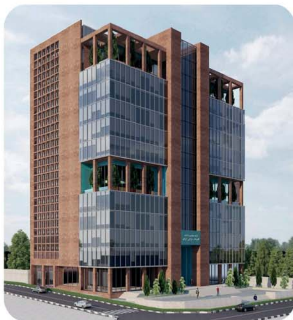
پروژه ساختمان اداری تاسیسات
