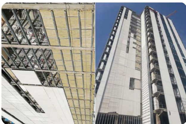
تصویر اجرا شده سازه LSF جداره پیرامونی و لایه سمند برد پوشش بیرونی
