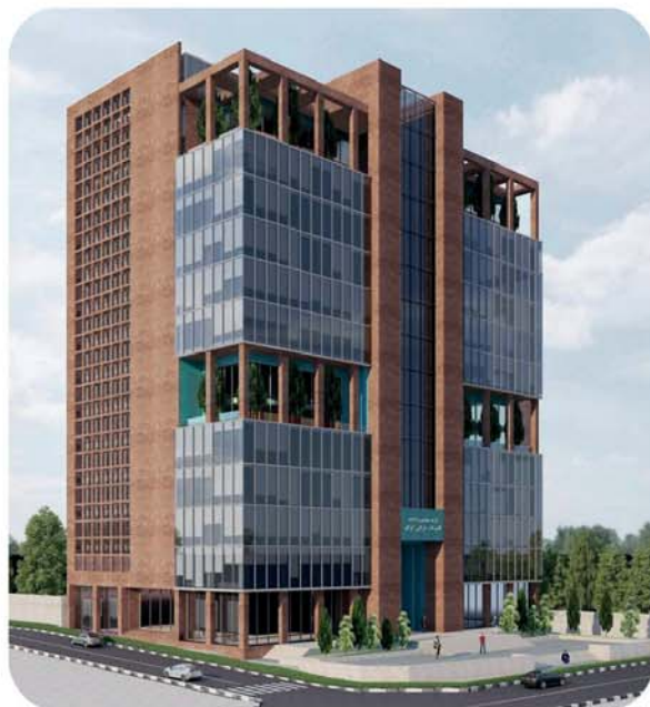
پروژه ساختمان اداری تاسیسات
