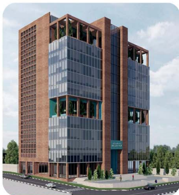
پروژه ساختمان اداری تاسیسات
