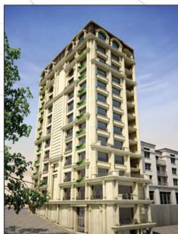
برج مسکونی توکلی
