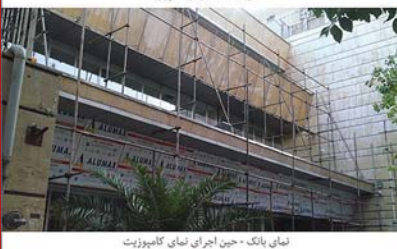
نمای بانک - حین اجرای نمای کامپوزیت
